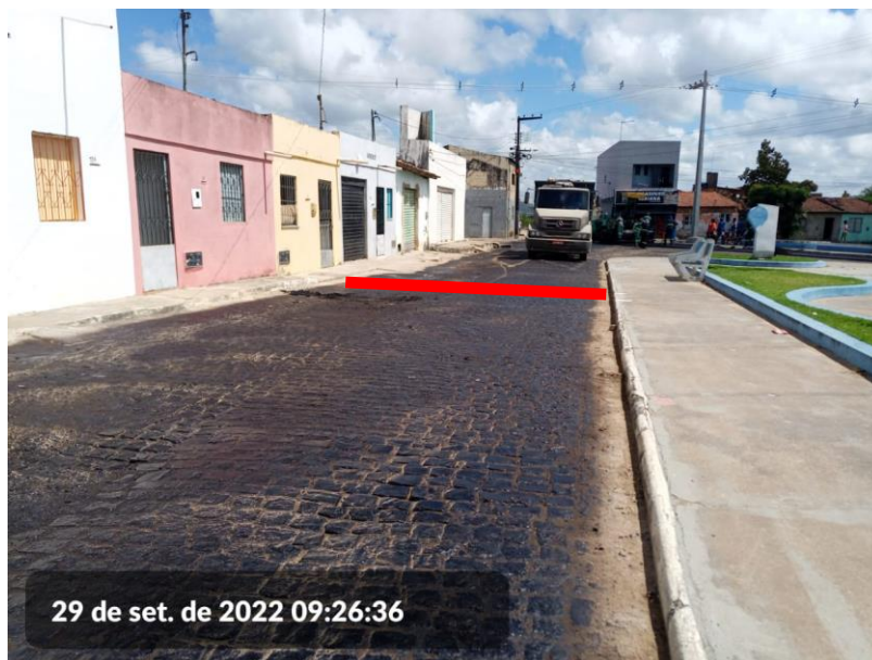
Imagem 04 – Praça São Domingos, em frente à casa nº18.
