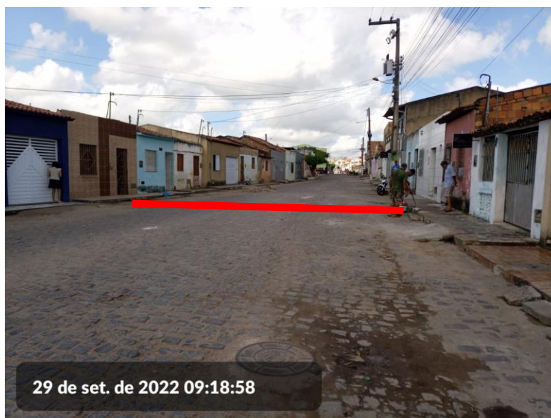
Imagem 07 – Rua Ademar de Oliveira, em frente à casa nº216.
